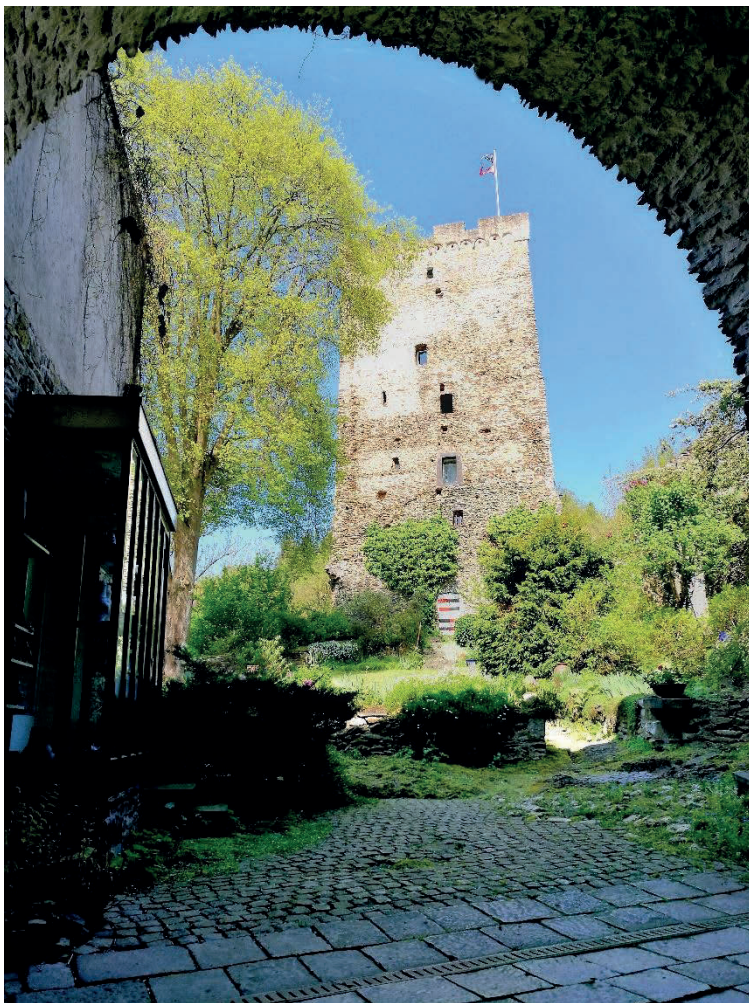
Burg Grensau – Blick in den Innenhof mit Bergfried
